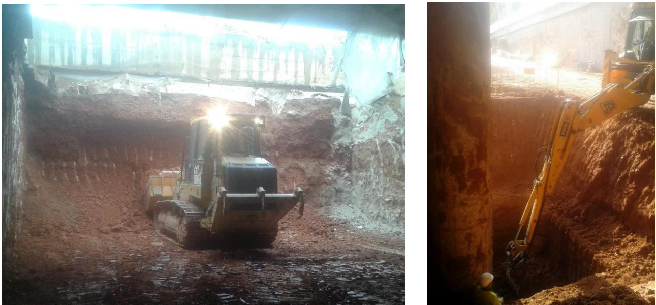
Fig. 5.- Maquinària treballant en els rebaixos de la Rampa 1.
