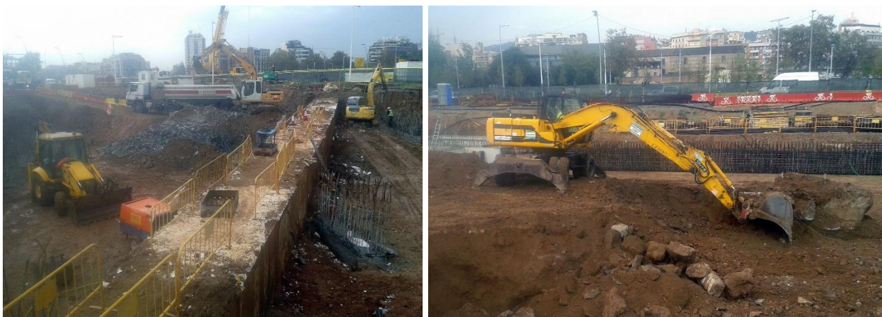
Fig. 7.- Maquinària treballant en els rebaixos del Pou 2.
