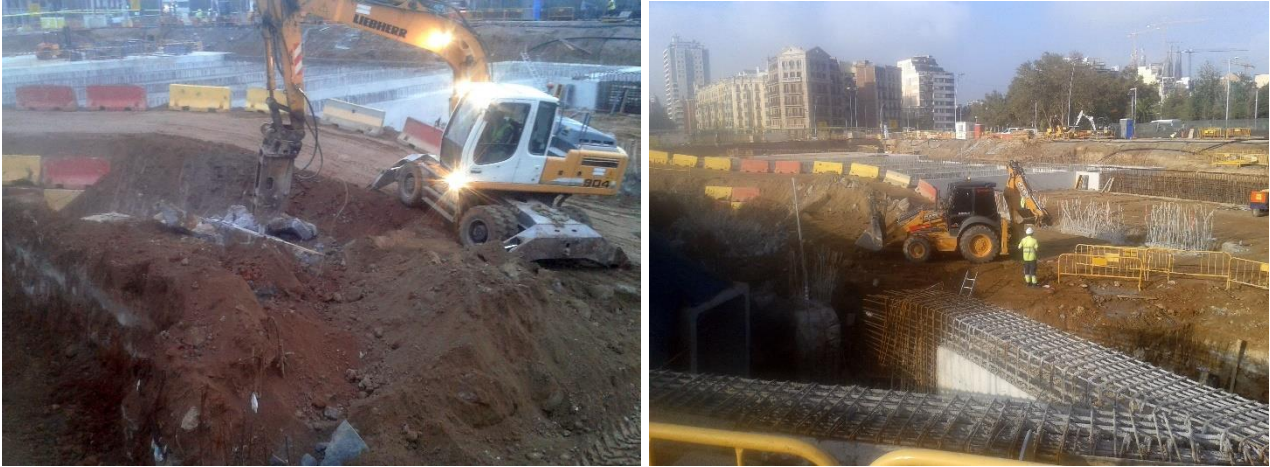
Fig. 6.- Maquinària treballant en els rebaixos del Pou 1.
